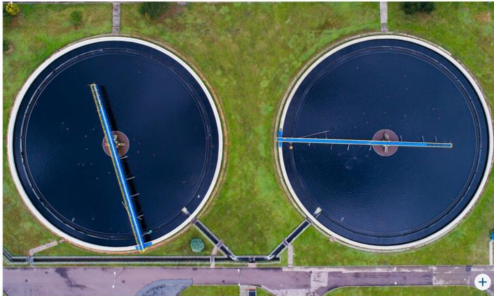
Luftaufnahme einer Kläranlage © Adobe Stock / Daniel Jędzura
